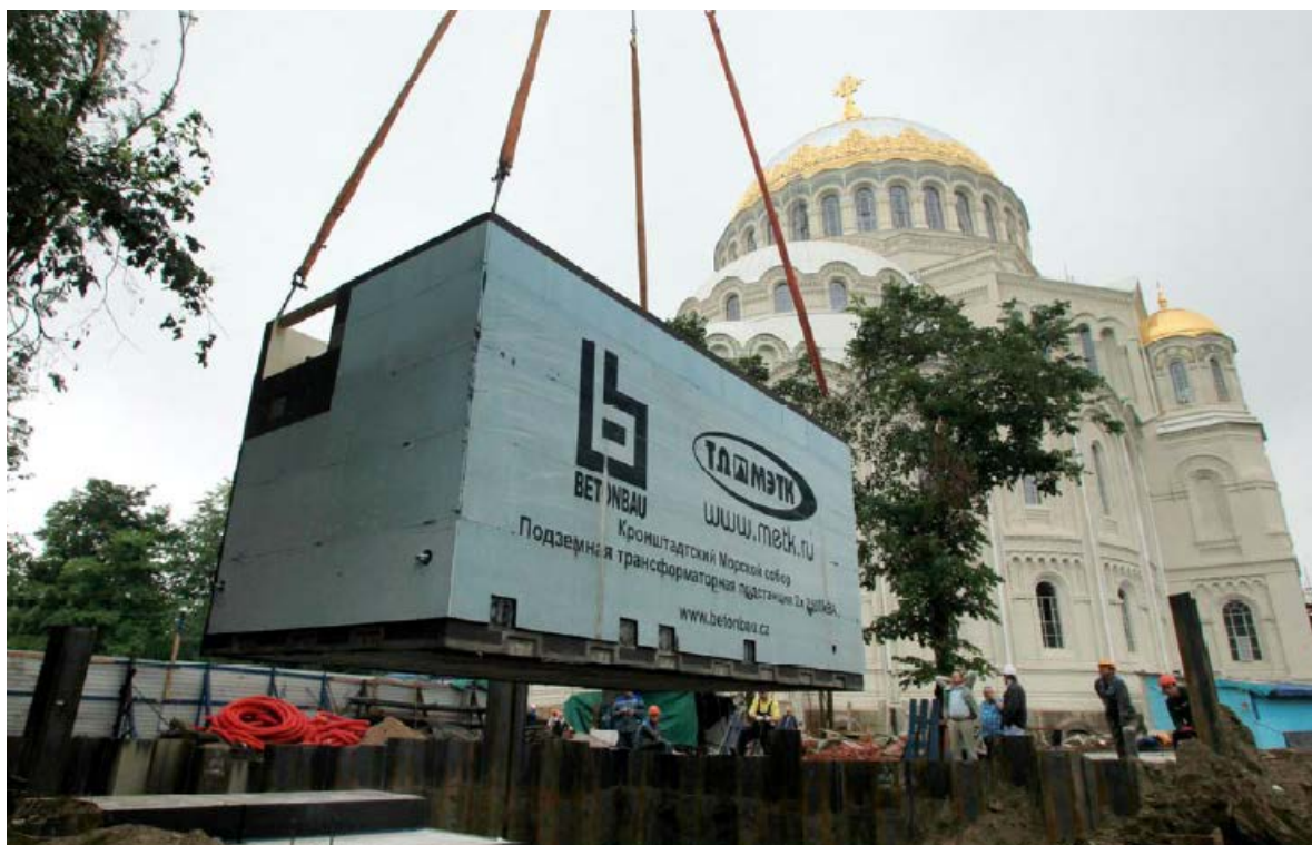
Рисунок 2 – Установка в котлован блока № 3 РУ ВН и НН
