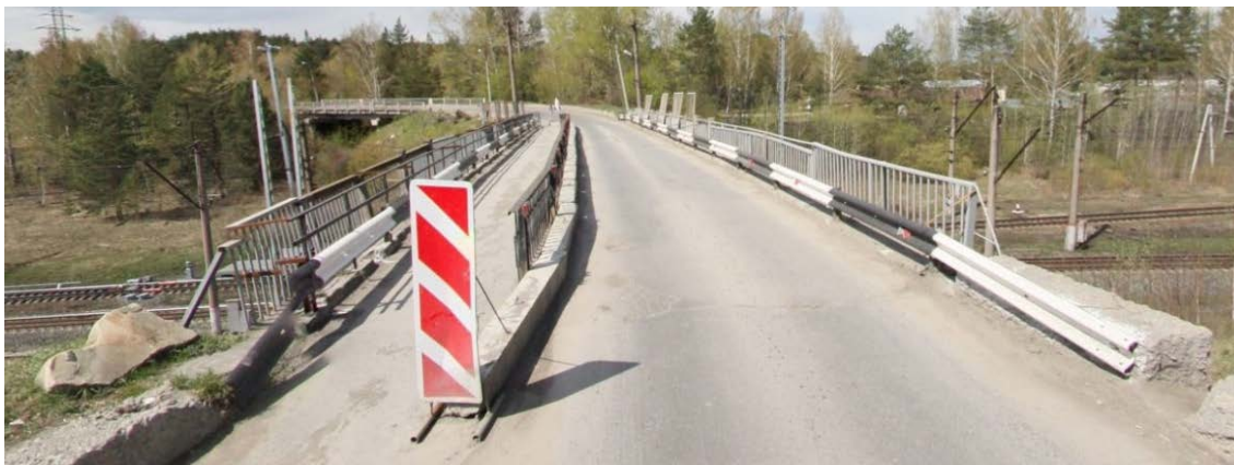
Рис. Фотоизображение путепровода: общий вид (вверху) и вид на проезжую часть и тротуар (внизу)
