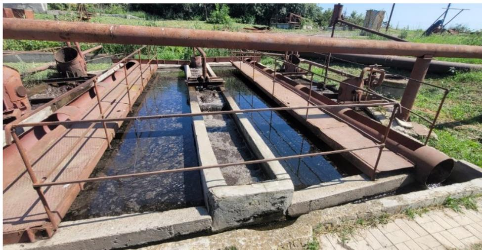
Концепция биологической очистки сточных вод с эрлифтными биореакторами (БОСЭБ) базируется на использовании сооружений с затопленной эрлифтной системой аэрации и илоразделением в самообновляющемся взвешенном слое. Эрлифтные биореакторы являются сооружениями для одновременной нитри-денитрификации, совмещенной с вторичным илоразделением.
