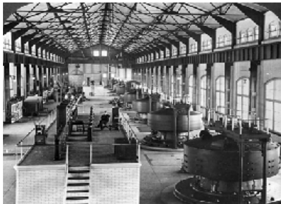
Рисунок 1 – Машинный зал первой в мире ГЭС переменного тока на реке Ниагара, «ГЭС Адамса», 1896 год
