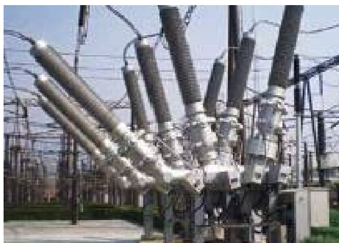
Рисунок 2 – Устройство 3AP1 DeadTankKompakt (DTC)
