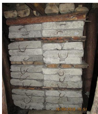
Рисунок 4 – Составная тумба с размерами 800 × 1000 × 1500 мм
