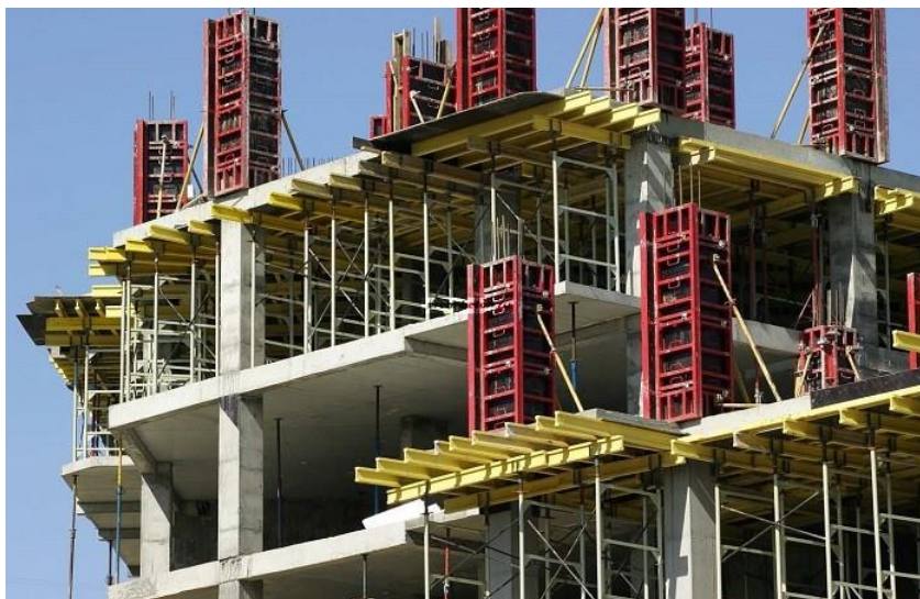
Рисунок 2 – Строительство монолитного здания
