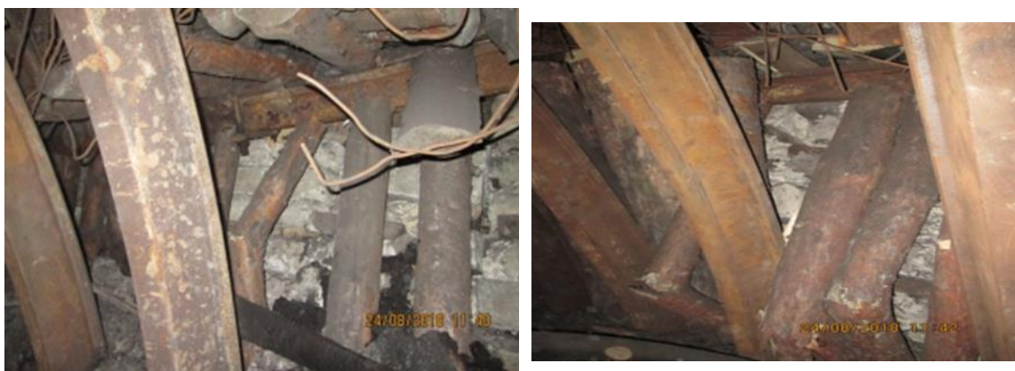
Рисунок 1 – Завал стоек органной крепи и первого ряда БЖБТ
